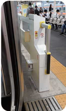
▲大久保駅に設置されているホームドア
